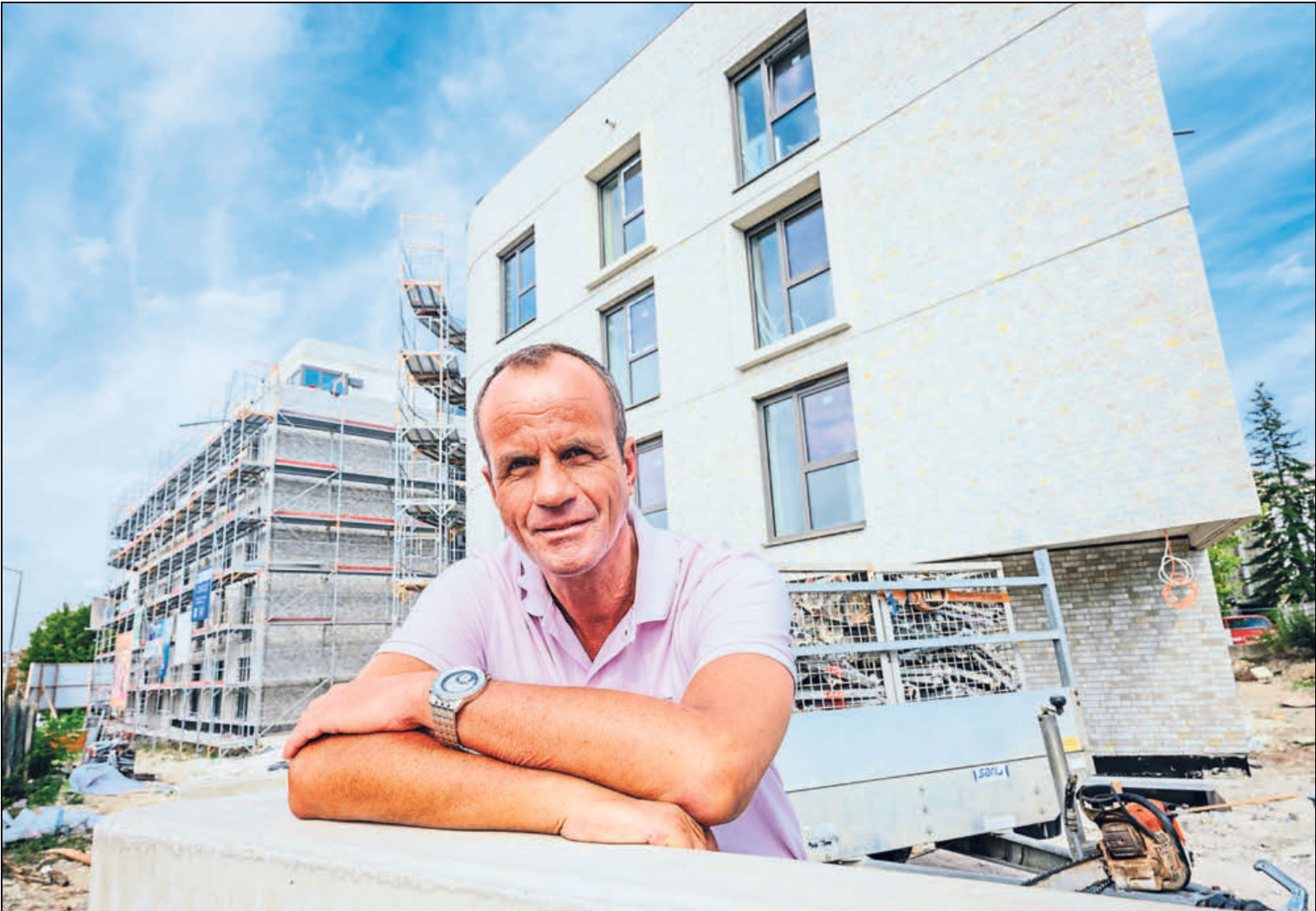
Vorstandssprecher Thorsten Mertens präsentiert den Neubau des Studentenwohnheims an der Warburger Straße in Paderborn. Die Archi-
