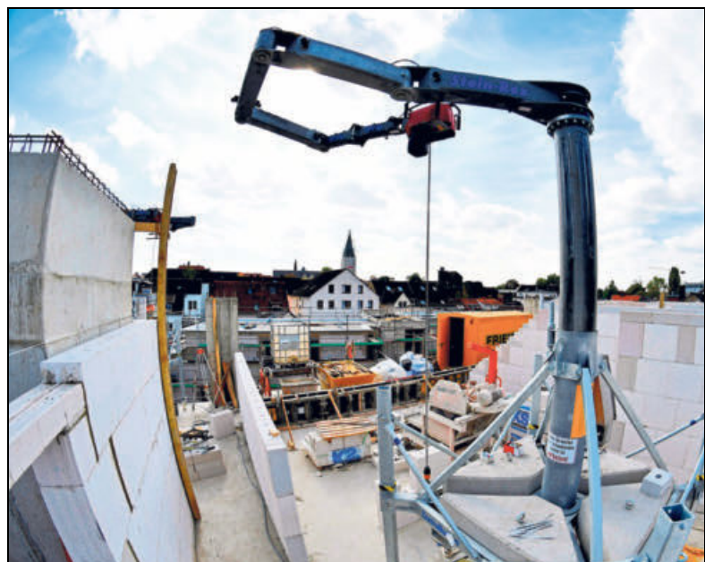
Über den Dächern von Paderborn entsteht neuer Wohnraum. Mit Blick auf den Dom auf der einen und dem Maspernturm auf der anderen Seite wird an der Heiersmauer gebaut. Foto: Ingo Schmitz
